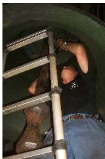
Alter Klöppel wird ausgebaut, 2009
